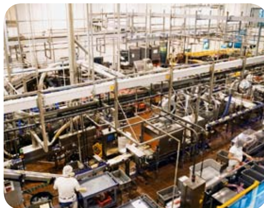
Catena in acciaio inossidabile usata in uno stabilimento di lavorazione del formaggio
