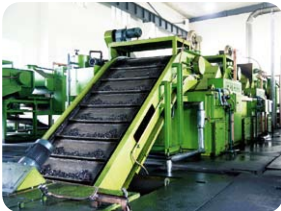
Linea di trasporto del forno utilizzata per il trattamento termico, per esempio carbonitrurazione, di rulli e bussole.
